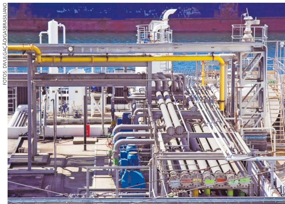
Gasoduto deve ficar pronto em 2018; as obras vão ser executadas pela GasBrasiliano
