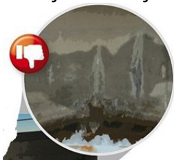
Figura 13. Concreto: Infiltração/Lixiviação
