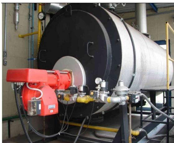
**Figura 1** – Foto da caldeira flamotubular ensaiada.
