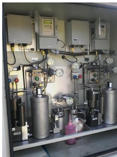
**Figura 4 – Painel do Sistema de Odorização**
