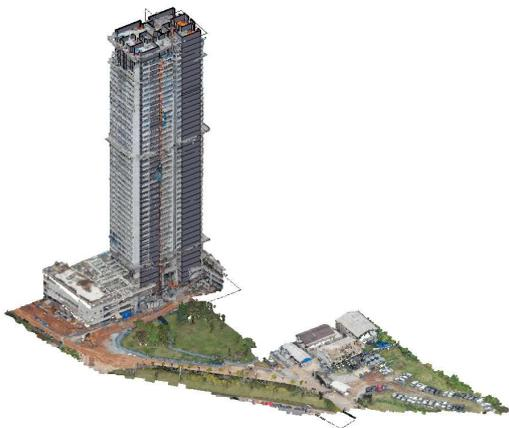
**Figura III** - Nuvem de pontos do teste de precisão relativa no eixo Z.
