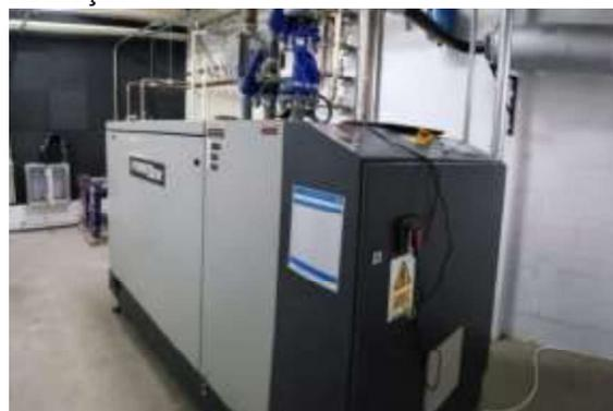
**Figura 5** – CHP Powerlink 50kWe Modelo ACG50S-6NG
