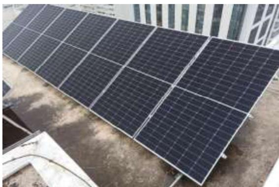
**Figura 2** – Painéis Solares EMSH550HC (Intelbras)
