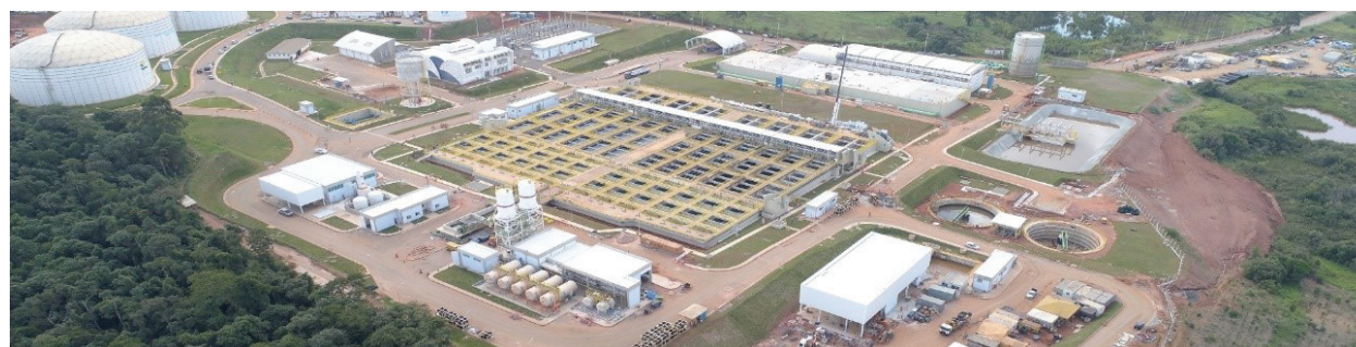
ETA Vargem Grande
