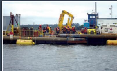
Tubulação sendo preparada para operação de soldagem, em balsa no centro da represa (com apoio de sistema de içamento e sustentação de tubulações)
