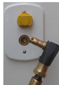
Figura 1 – Tomada GN Finalizada e Instalada na Configuração Embutida
