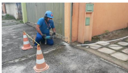
Figura 2 – Visita em canteiro de obras da Sial.
