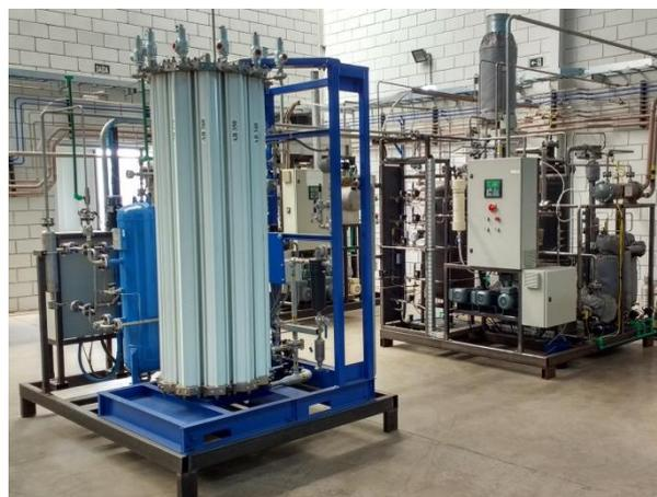
**Figura 1** – Unidade integrada de produção de hidrogênio ultrapuro
