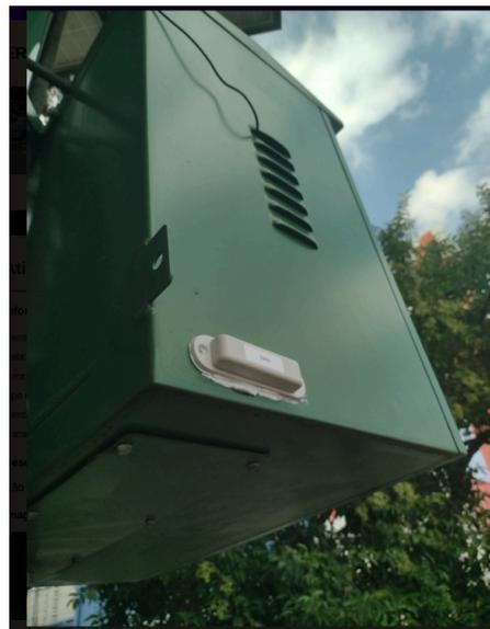
Figura 2 - Etiqueta RFID instalada em painel metálico de ERP / CRM
