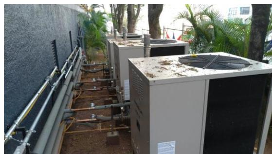
Figura 1 – GAHPs instalados no local piloto e parte dos transmissores de temperatura.
