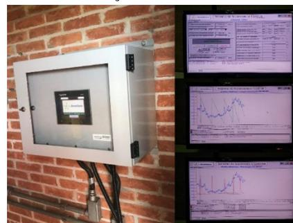
A lógica desenvolvida em laboratório e refinada em campo (ETC Bilac), atingiu excelente resultado no que diz respeito a operação automática, garantindo taxas de odorização reais próximas ao set-point,
