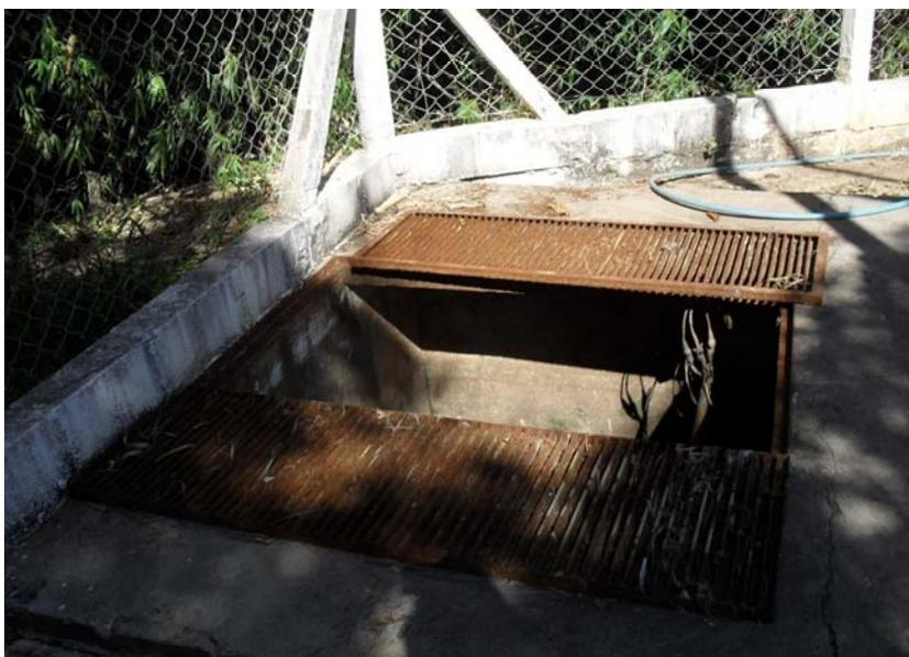
*Elevatória Final em condições de abandono. Grades de segurança do piso abertas, com risco de acidentes.*
