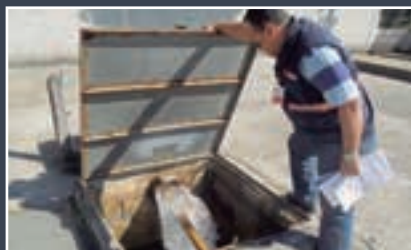
Fiscalização do sistema de abastecimento de água de São José dos Campos, SP
