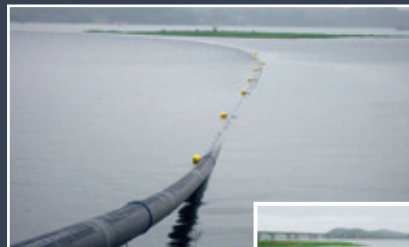
Tubulação de 20 polegadas, sem revestimento de concreto e com 1,8 km de extensão, a ser inserida no duto resultante do furo direcional.
