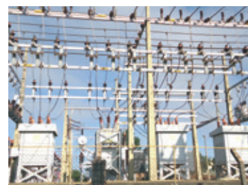
Fotos de fiscalizações da rede de distribuição SE Assis Vale Paranapanema
