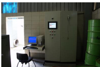
Figura 3 – Painel tipo armário e computador onde os dados são armazenados.
